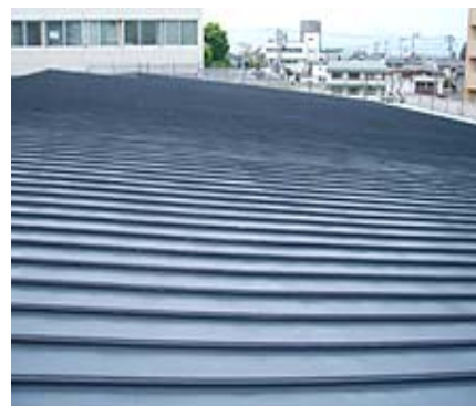
施工後の金属屋根
